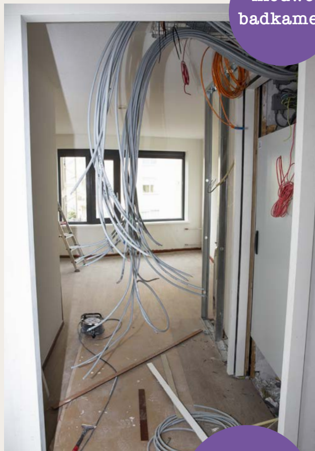
93 appar- tementen in aanbouw
